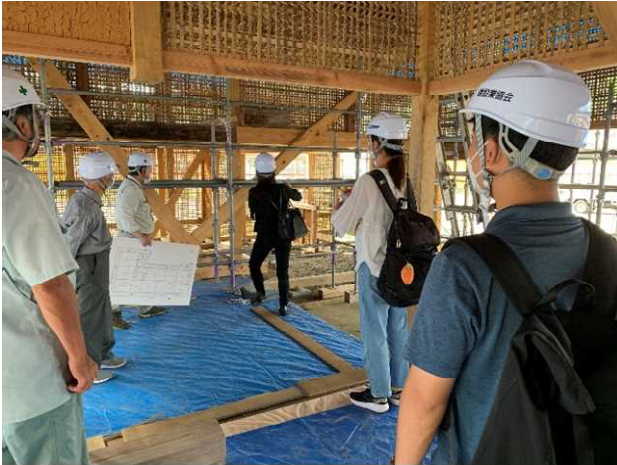
復旧作業中の主屋での説明
